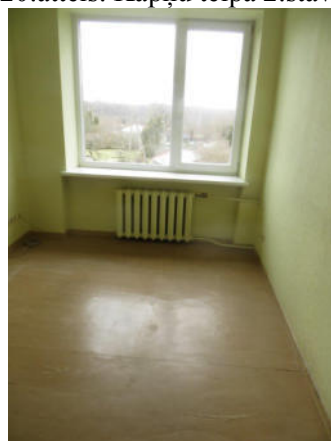
22.attēls. Kabinets 2.stāvā (telpa Nr.11)
