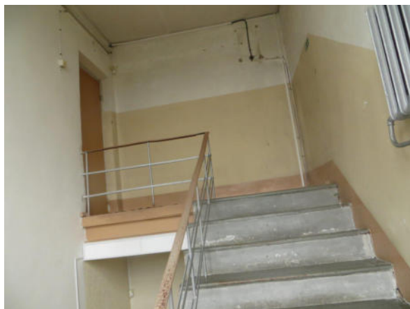
20.attēls. Kāpņu telpa 2.stāvā
