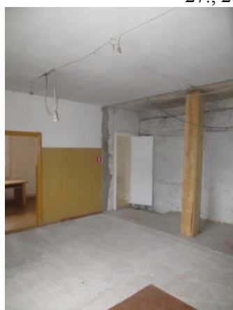
29.attēls. Piebūve (telpa Nr.17)
