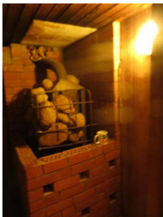
35.attēls. Piebūve (telpa Nr.23- pirts telpa)
