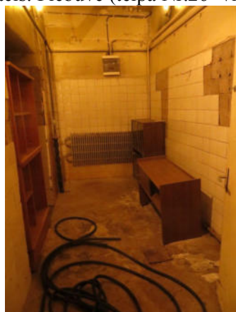
33.attēls. Piebūve (telpa Nr.32- palīgtelpa)
