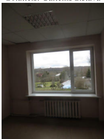
23.attēls. Kabinets 2.stāvā (telpa Nr.12)
