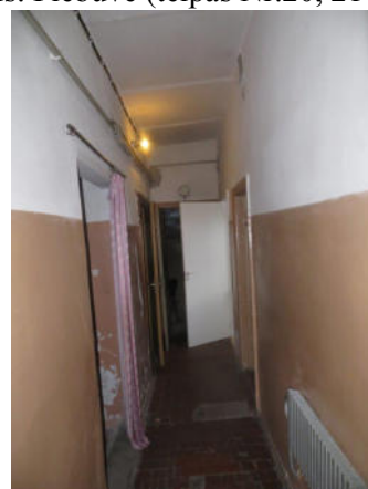
32.attēls. Piebūve (telpa Nr.27- gāitenis)
