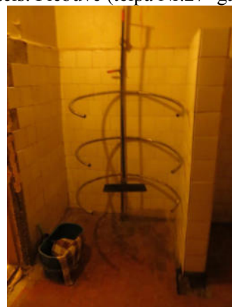
34.attēls. Piebūve (telpa Nr.24- dušas telpa)
